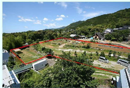
建設用地を黒潮園屋上より望む
